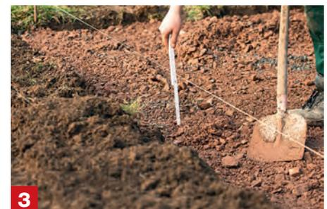
**3 Höhenschnur spannen** Nun spannst du eine Maurerschnur zwischen den Begrenzungspfählen auf der fertigen Höhe der Oberkante der Betonplatten aus. Dann die oberste Schotterschicht bis ca. 15 cm unter der Schnur einfüllen.
