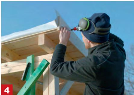
**Ortgangbretter anschrauben** Die Bretter werden in Dachneigung an die Konterlattung angeschraubt. Sie sollten unten ca. 1 cm über das Schalungsbrett und 1,5 cm über die Trauflinie hinausragen.
