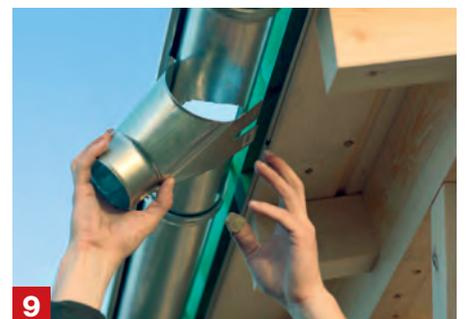
**Rinnenstützen installieren** Miss das letzte Rinnenstück in der passenden Länge aus, schneide es ab, positioniere den Rinnenstützen und schneide mit der Blechschere ein Loch für das abfließende Wasser aus. Bevor du die Rinne einhängst, verbinde alles mit Laschen. Zuletzt hakst du den Rinnenstützen ein.
