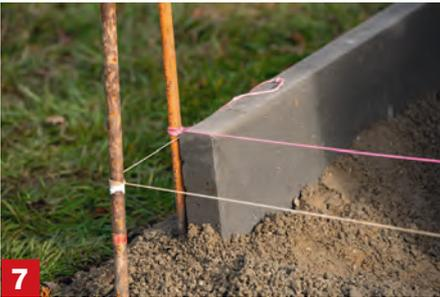
**Randsteine fixieren** Wenn alle Steine exakt stehen, kannst du die keilförmigen Betonstützen auf beiden Seiten der Steine festdrücken und glätten. Da Randsteine verhindern, dass Pflasterbeläge im Laufe der Zeit wandern, müssen sie stabil einbetoniert werden!
