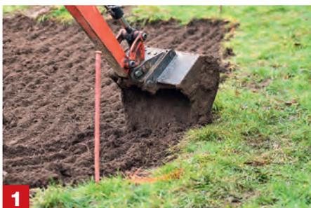
**1 Erde ausheben** Zunächst steckst du die Fläche grob mit Schnurstangen ab und hebst die Erde mit Hilfe eines Baggers aus: ca. 25 cm tief ohne, ca. 37 cm tief mit Frostschuttschicht (s. oben). Die Ränder begradigst du mit einem Spaten.
