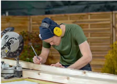
**Holzteile zusägen** Dabei orientierst du dich an der Schnittliste und dem Bauplan. Tipp: Sieh dir auf jeden Fall die Selbstermachervideos zum Thema an (siehe Kasten rechts unten).
