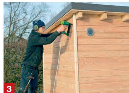
**Bretter in Sparren einpassen** Sobald du oben an die Sparren kommst, musst du ein langes Brett auf Position halten und die Sparren anzeichnen. Mit der Stichsäge sägst du die Aussparungen aus. Genauso gehst du auf der Rückseite und an den Seitenwänden vor. Sobald du an die Pfetten und die Dachschräge kommst, schneidest du die Ecken aus. Mithilfe einer Schmiege überträgst du die Dachneigung auf dein Brett und schneidest mit der Handkreissäge oder Stichsäge die Neigung an.
