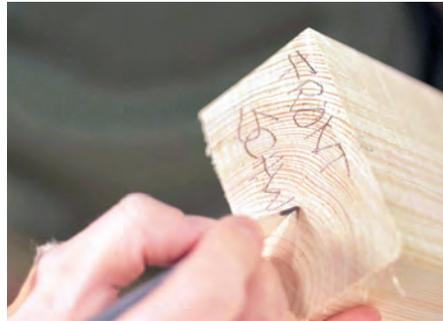
**Ordnung** Jedes Holz beschriftest du auf der Stirnholzfläche, z.B. „BP“ für Bodenplatte. Senkrechte Hölzer nummerierst du von links nach rechts durch und sortierst alles übersichtlich.
