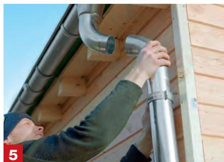
**Montage der Fallrohre** Zuletzt steckst du auf den Ablaufstutzen einen Bogen auf und drehst ihn zu einer Holzstütze. Mit dem Fallrohr bestimmst du die Position der ersten Rohrschelle, bohrst für den Nagel ein Loch vor und schlägst ihn nicht ganz ein. Den Platz zwischen den beiden Bögen überbrückst du mit einem Stück Fallrohr. Dann misst du die zweite Schelle und das letzte Stück Rohr aus und kannst es montieren. Fertig!
