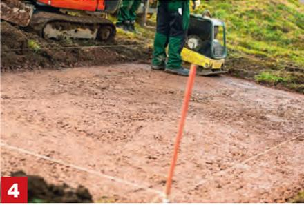
**Tragschicht verdichten** Die oberste Schicht verdichtest du mehrfach mit einer Rüttelplatte – je gründlicher, desto stabiler steht später dein Haus. Kontrolliere dabei immer die Höhe der Schichten. Du kannst die Schnur zum Messen auch hilfsweise kreuz und quer über der Fläche spannen.
