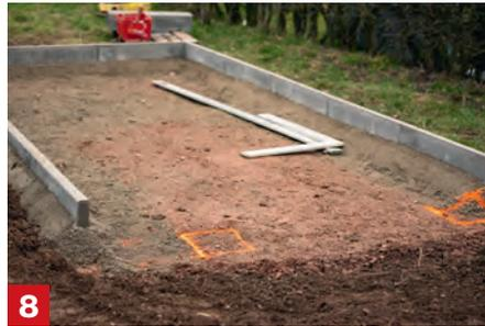
**Punktfundamente vorbereiten** An der Seite, an der die Punktfundamente entstehen, noch keine Randsteine setzen. Hier misst du die exakte Position der Punktfundamente aus und markierst die Stellen. Aus Brettern baust du eine Holzverschalung: Höhe 25 cm, Innenmaße: 30 x 30 cm.
