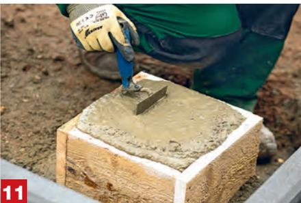
**Anker setzen** Mit einer Kelle Luft aus dem Beton lassen und verdichten. Die Fläche muss waagrecht sein. In den feuchten Beton H-Anker stecken. Alternativ Aufschraubanker verwenden. Die Auflagefläche für den Balken soll auf Schnurhöhe sein.
