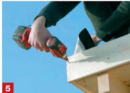
**Firstbretter anschrauben** Beim Firstbrett gehst du ganz ähnlich vor. Zunächst befestigst du je ein Brett links und rechts am Ortgang und schneidest Überstände ab. Danach klebst du die Unterdeckbahn an die Ortgangbretter.
