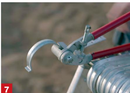
**Rinnenhaken biegen** Die Haken biegst du mit einer Rinneneisen-Abbiegezange (geht auch im Schraubstock) und passt sie an die Dachneigung an. Um die Biegestelle zwischen dem höchsten und tiefsten Haken zu finden, reihst du alle bündig nebeneinander auf und ziehst einen Strich vom ersten zum letzten, tiefsten Biegepunkt über alle Haken.
