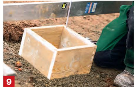
**Fundamente setzen** Nun hebst du zwei 80 cm tiefe Löcher an den markierten Stellen aus, füllst sie mit leicht feuchtem Fertigbeton aus (nicht flüssig!) und verdichtest ihn. In den feuchten Beton schlägst du die Verschalungen ca. 5 cm tief ein, sodass die Oberkante 8 cm unter Schnurhöhe liegt.
