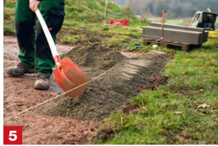
**Betonsockel für Randsteine anlegen** Damit die Platten deines Fundaments an der Seite Halt finden, setzt du Randsteine in einen Betonsockel. Dafür rührst du Fertigbeton leicht feucht an (Achtung: bindet in 30 bis 60 Min.) und schüttest ihn an den Rändern zu kleinen Haufen auf.
