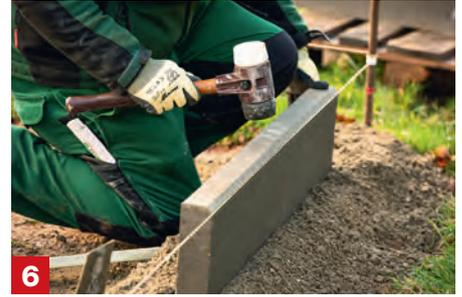
**Randsteine setzen** Nun platzierst du den ersten Randstein, klopfst ihn mit dem Gummihammer auf Schnurhöhe fest und kontrollierst mit der Wasserwaage. Stein für Stein geht es entlang der Schnur weiter. Damit die Steine nicht umfallen, häufst du auf beiden Seiten etwas Beton als Stütze an.
