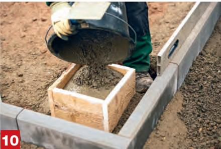
**Punktfundamente fertigstellen** Nun kannst du die noch fehlenden Randsteine setzen. Im Anschluss verflüssigst du den restlichen Beton mit etwas Wasser und füllst ihn bis zur Oberkante in die Verschalungen ein.
