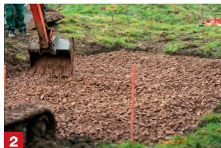
**2 Schotter einfüllen** Der Untergrund wird mit einer Rüttelplatte geglättet. Dann füllst du Schotter ein und verdichtest ihn lagenweise alle 10 cm. Bzgl. des für deine Region geeigneten Schotters für Frostschutz- und Tragschicht berät dich dein Baumarkt.
