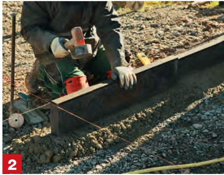
**2 Randsteine setzen** Nun platzierst du den ersten Randstein, klopfst ihn mit dem Gummihammer fest und kontrollierst die Position. Arbeite dich Stein für Stein entlang der gespannten Schnur voran.
