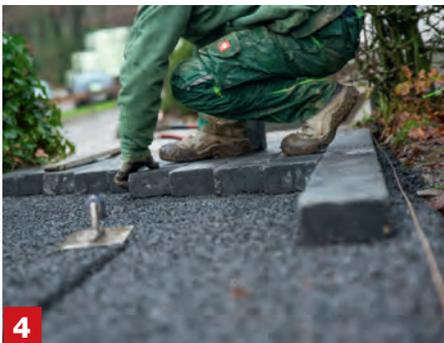
**4 Reihe für Reihe verlegen** Nun arbeitest du dich Steinreihe für Steinreihe vor. Glätte das Splittbett bei Unebenheit ggf. nochmals mit einer Glättkelle nach. Verlege nur ganze Steine, bis die gesamte Wegfläche vollständig mit Steinen bedeckt ist.
