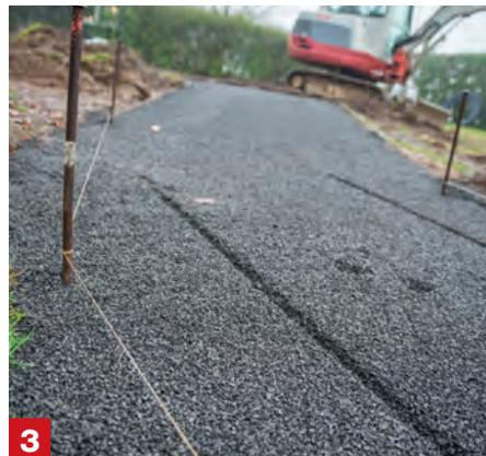
**Schnurgerüst anlegen** Auch bei einem Weg musst du ein Schnurgerüst anlegen, an dem du dich bei der Höhe der Tragschichten orientierst. Kurven bildet das Schnurgerüst nur grob ab.
