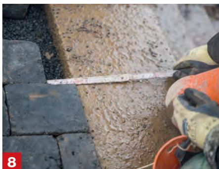
**8 Halbe Steine ergänzen** Zum Schluss füllst du bei einem Halbverband oder anderen Legemustern noch die entstandenen Lücken mit kleineren Steinen. Wie du Pflastersteine mithilfe eines Steinknackers auf die richtige Größe brechen kannst, liest du auf Seite 17.
