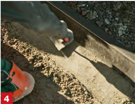
**4 Betonstütze anbringen** Sind alle Steine eingesetzt und ausgerichtet, bringst du beidseitig eine Rückenstütze aus Beton an und streichst sie mit einer Kelle glatt. Bevor es mit dem Splittbett weitergeht, musst du den Beton austrocknen lassen.
