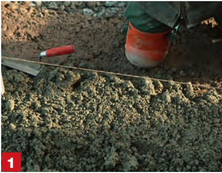
**1 Sockel anlegen** Zunächst rührst du Fertigbeton an (bindet in 30 bis 60 Min.) und trägst ihn ca. 15 cm dick in einen ca. 5 cm tiefen Graben auf. Die Steine stehen später in einem ca. 10-cm-Sockel.
