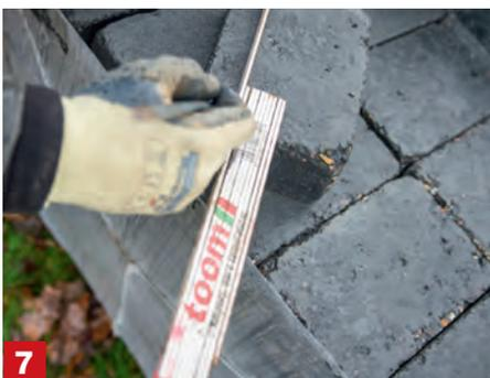
**7 Fugen einhalten** Beim Verlegen solltest du auf eine Fugenbreite von 3 bis 5 mm achten. Bei Steinen mit ungeraden Kanten entsteht dieser Abstand fast von selbst, bei exakt geschnittenen Betonplatten sieht es etwas anders aus. Achte am besten auch auf die Angaben des Steinherstellers.
