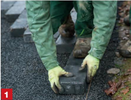
**1 Kopfüber arbeiten** Das Wichtigste vorweg: Beim Pflastern darfst du das abgezogene Splittbett auf gar auf keinen Fall mehr betreten. Du arbeitest dich deshalb immer auf dem bereits gepflasterten Wegstück sitzend oder hockend „kopfüber“ zum Ende der Strecke voran.
