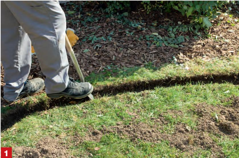
**Kante abstechen** Beginne mit dem Spannen einer Richtschnur von einem zum anderen Ende der geplanten Kanten und fixiere sie an den Endpunkten an Schnurstangen oder Pflöcken. Stich die Kante entlang der Schnur ab. Die Tiefe richtet sich nach der Höhe des Blechs.
