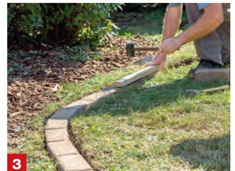
**3 Randsteine einsetzen** Jetzt kannst du die Rasenrandsteine je nach gewünschter Optik nebeneinandersetzen und mit einem Gummihammer festklopfen. Abschließend den Graben neben den Steinen noch mit Sand oder Erde verfüllen und vorsichtig antreten. Fertig!
